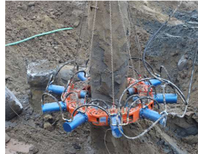
上图为：9个模块破1m的桩
