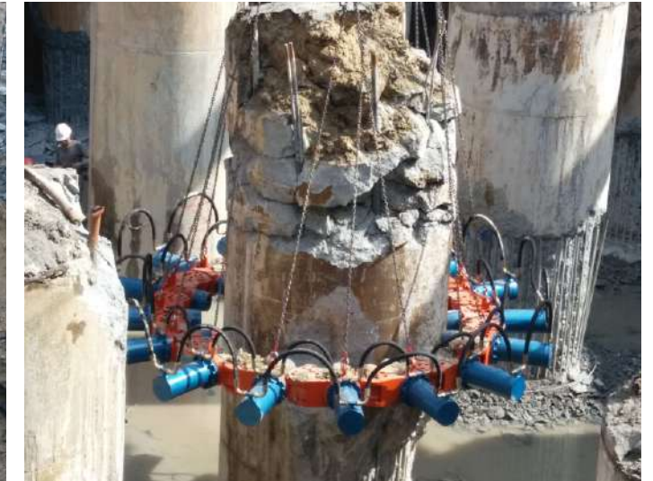
上图为：16个模块破2.2m的桩
