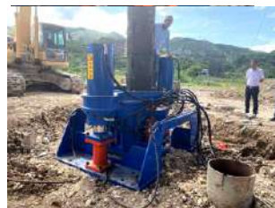
根据PC工法桩大小 更换齿板
